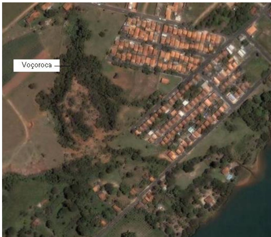
Figura 52: A voçoroca possui várias ramificações que se encontram parcialmente cobertas de vegetação. Algumas de suas cabeceiras, no entanto, estão em franca expansão, incrementada por intervenções de movimentos de terra inadequados.
