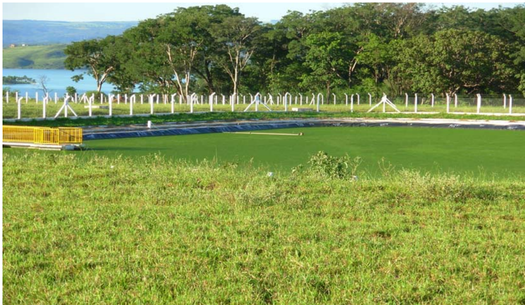
Figura 56: Estação de tratamento de esgotos da cidade (SABESP).
