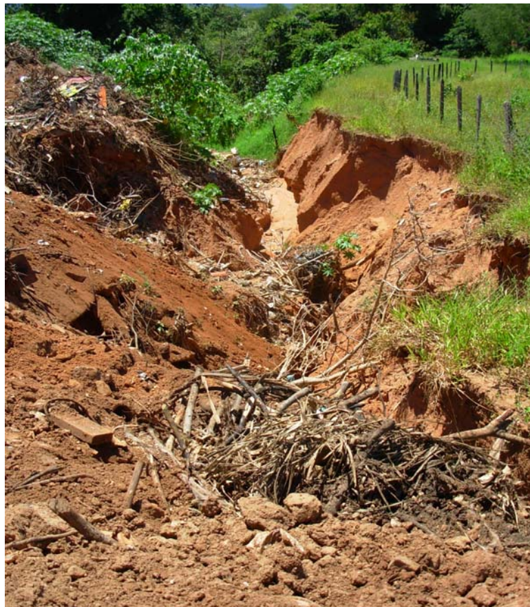
Figura 29: O entulho e galhos de árvores não representam solução no processo de contenção da voçoroca.
